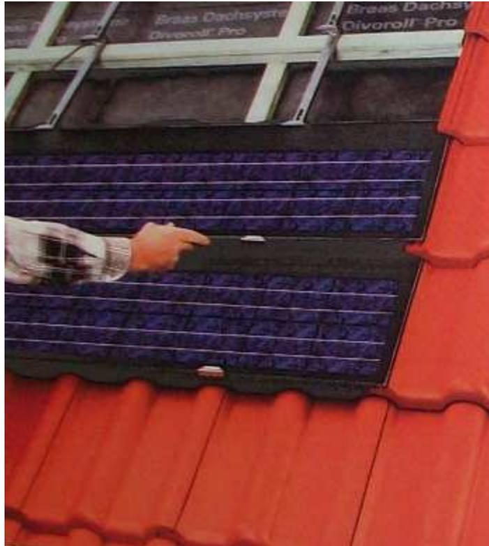
**Fig. 5.29. Módulos especialmente diseñados para sustituir a la tejas convencionales.**
