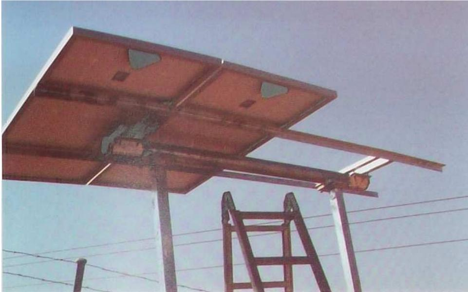
Fig. 5.88. Los módulos se posicionan convenientemente, hasta que los taladros (huecos) de los marcos de aquéllos queden enfrentados con los correspondientes taladros en los perfiles en "L" de la estructura.
