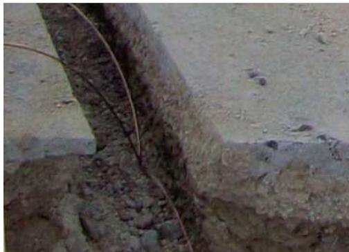
**Fig. 5.17.1.** Conductores desnudos de puesta a tierra
