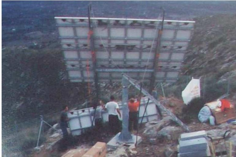
**Fig. 5.9. Estructura con un único apoyo, que puede albergar hasta 32 módulos.**
