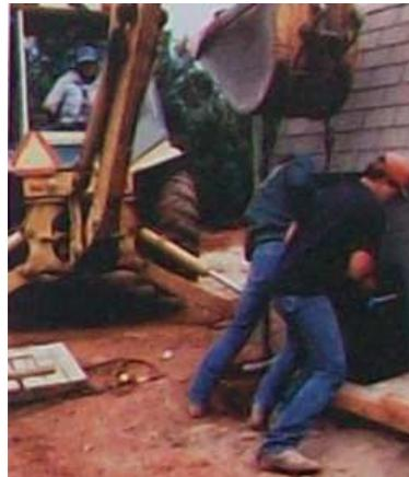
**Fig. 5.54. Las soluciones adoptadas para el transporte y manipulación de las baterías pueden ser muy diversas y variopintas e inseguras.**
