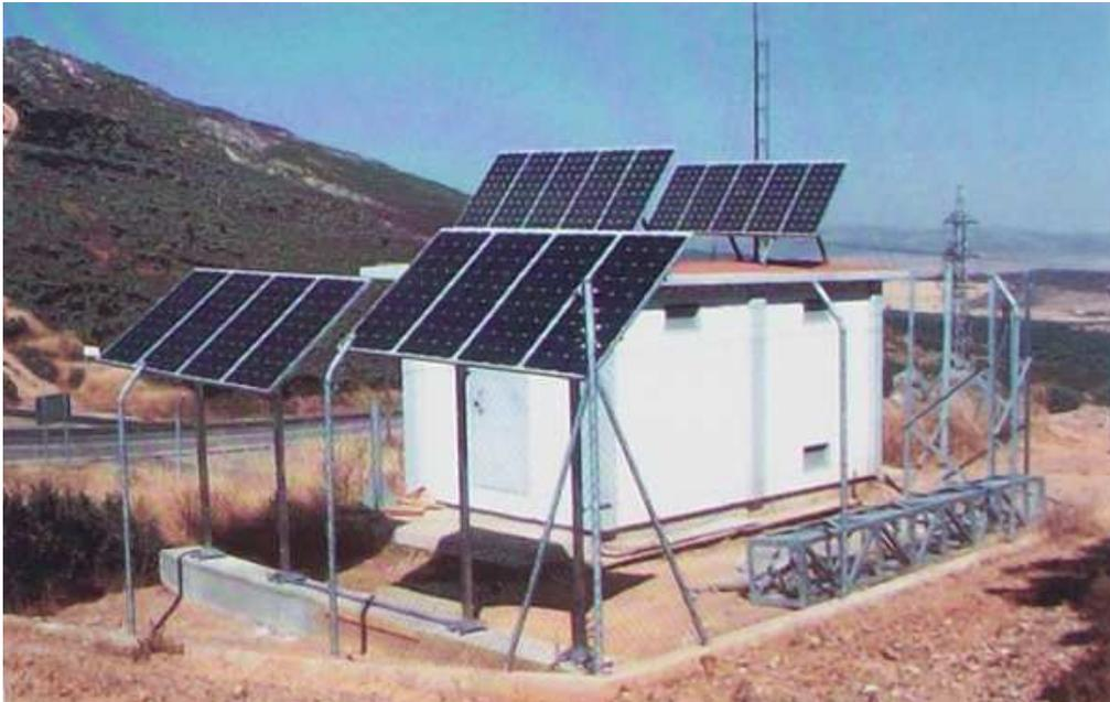
**Fig. 5.92.** La instalación exterior ya está terminada. Sólo falta montar los acumuladores y demás elementos auxiliares en la caseta construida al efecto, y que también sirve para albergar los equipos de transmisión.
