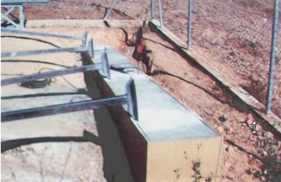
**Fig. 5.84.** Las patas de la estructura, preparadas para ser atornilladas en la base de hormigón. En este caso se usarán tacos químicos.
