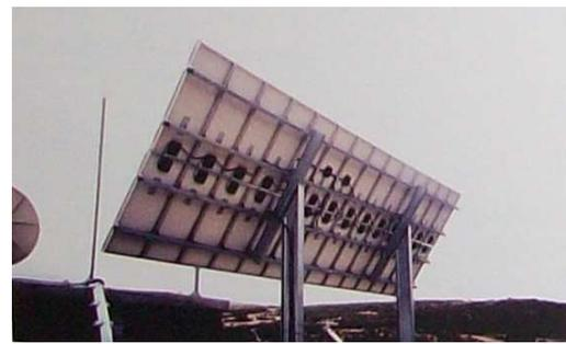
**Fig. 5.47.** Montaje y conexión de los paneles en una estructura. A la derecha, un panel ya montado y conectado.
