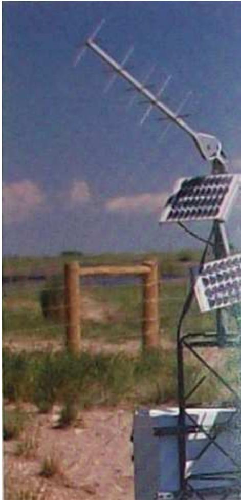
**Fig. 5.36. Montaje incorrecto de los paneles. Obsérvense las sombras proyectadas y el anclaje poco seguro e inestable.**
