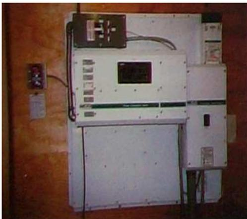
Fig. 5.76. Ejemplo de montaje integrado. Los elementos de regulación, acondicionamiento y desconexión se montan sobre un mismo panel.
