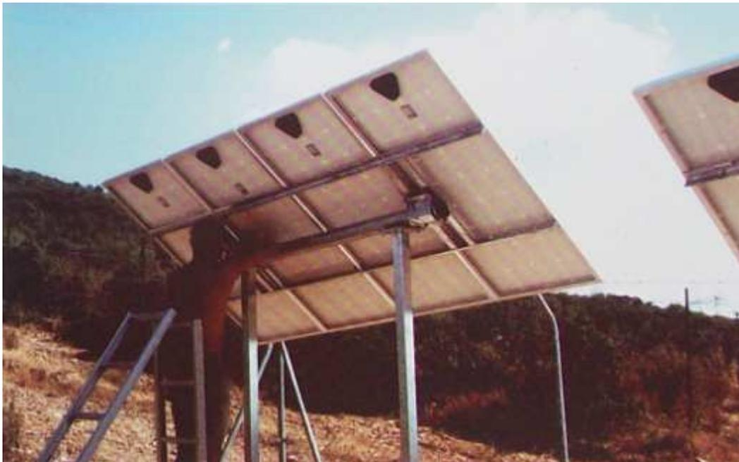
Fig. 5.89. Una vez atornillados los módulos, todo el panel se gira alrededor del tubo grueso hueco, que sirve de eje, hasta encontrar el ángulo indicado para cada caso, bloqueándolo en
