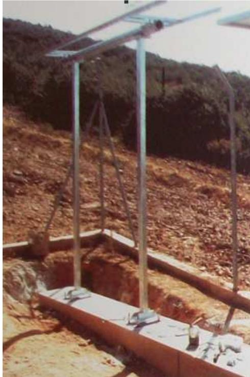
**Fig. 5.86.** La parte superior de la estructura, una vez montada
