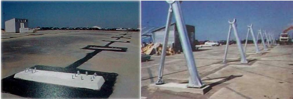
Fig. 5.15.1. Cimentación ya terminada y preparada para recibir las estructuras (izquierda). Parte inferior de las estructuras, ya ancladas sobre la base cimentada (derecha).
