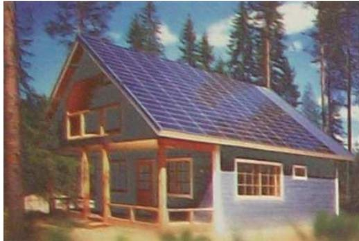
**Fig. 5.4.** Estos módulos de silicio amorfo descansan directamente sobre el tejado, no siendo preciso construir una estructura soporte separada.
