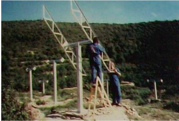
**Fig. 5.23** En este diseño, las dos grandes vigas reticuladas de cada lado vienen ya a la obra listas para se acopladas de forma relativamente sencilla.
