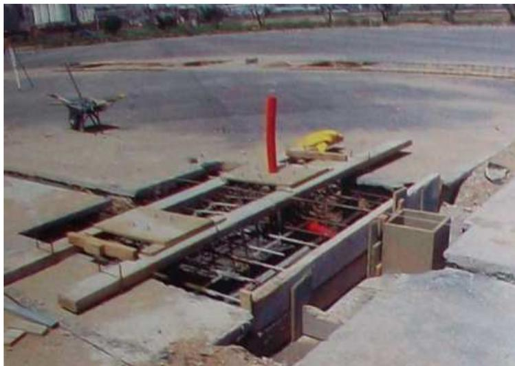
**Fig. 5.14.1.** Aspecto de la obra, esperando a que la primera capa de hormigón frague.
