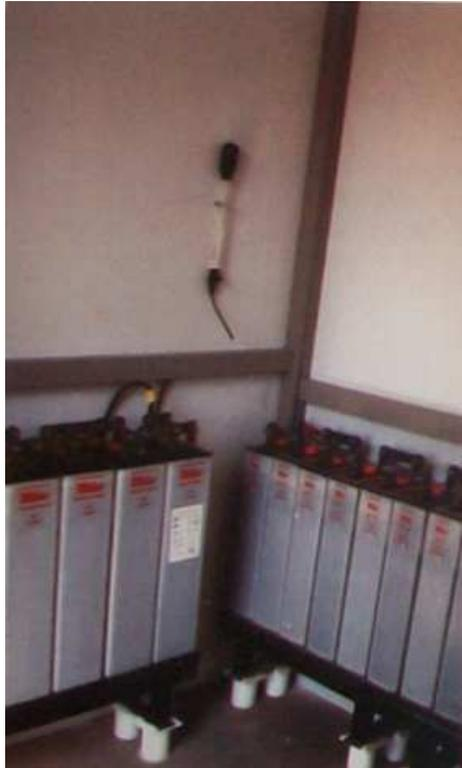
**Fig. 5.94.** Los acumuladores, una vez montados. Obsérvense los separadores de material aislante que se colocan bajo las patas de la base.
