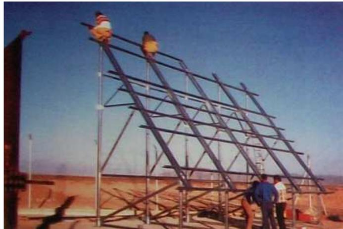
**Fig. 5.21.** En las estructuras de mayor tamaño, el montaje es una tarea que comporta riesgo, y no puede dejarse en manos de operarios inexpertos.
