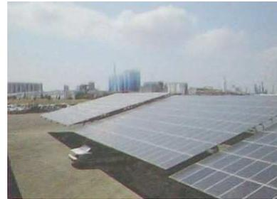
**Fig. 5.48. Aspecto final, una vez montado todos los paneles en la estructura.**
