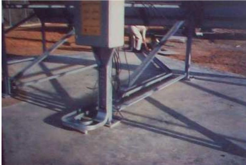
**Fig. 5.8. Ciertas partes de la estructura pueden servir también para albergar y conducir el cableado que va hasta la arqueta que ubica la caja de conexiones principal.**
