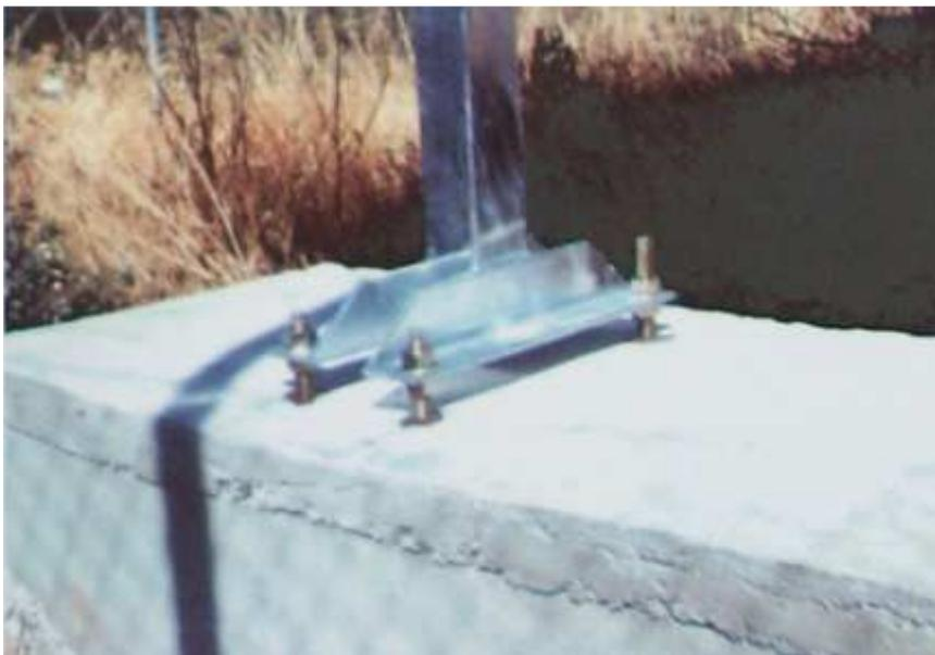
**Fig. 5.85.** Detalles de la base de la estructura, una vez atornillada. Obsérvense las tuercas de nivelación (las inferiores).
