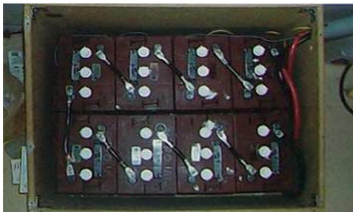
**Fig. 5.66.** Obsérvense la geometría lineal de los cables de interconexión de las baterías, no sometidos a esfuerzo. En el supuesto de que se alterase la disposición de las baterías, los cables de interconexión podrían resultar inadecuados. Obsérvense también la ausencia de fundas protectoras en las conexiones.
