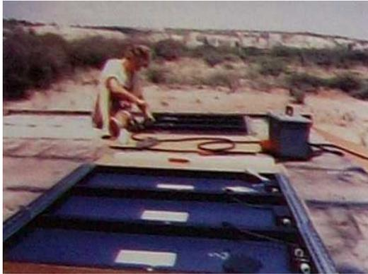
**Fig. 5.45.** Conexión y ensamblado de módulos. Obsérvense los perfiles que se fijarán finalmente a la estructura.
