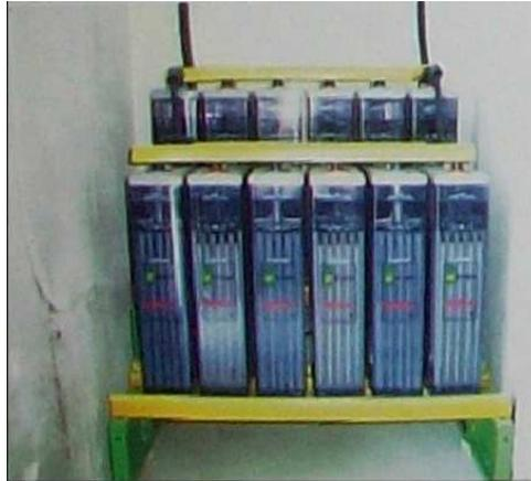
**Fig. 5.56.** Baterías colocadas sobre una bancada. Obsérvese cómo el espacio que existe entre la bancada y el suelo permite las posibles operaciones de limpieza de éste.
