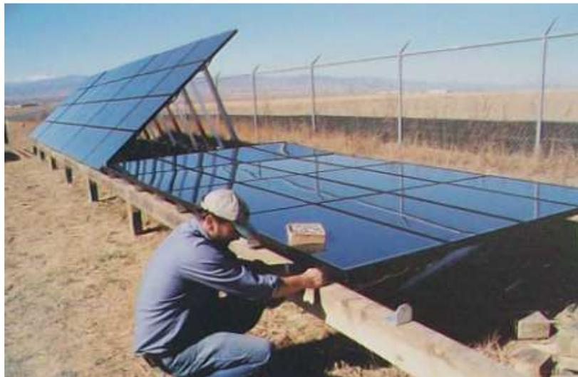
**Fig. 5.27.** Proceso final del montaje de los paneles pre-ensamblados en la estructura de la figura anterior (27). Los paneles se disponen horizontalmente, como se observa en la fotografía, el operario asegura las uniones en la parte frontal, y posteriormente se levantan, terminando por atornilla las patas a las piezas metálicas del rastrel posterior.
