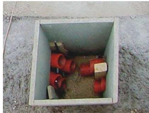
**Fig. 5.74. Apertura de un paso bajo el pavimento por el que discurrirá el (caja) de registro cableado.**
