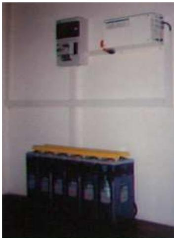
**Fig. 5.83.** Un acabado pulcro y profesional implica necesariamente el cuidado de la estética de la instalación. La utilización de canaletas cubre-cables favorece el aspecto final.
