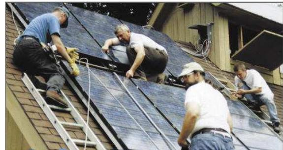
Fig. 5.50.1. En el Montaje de paneles sobre estructura en tejados inclinados es conveniente comenzar por la hilera situada en la parte superior.
