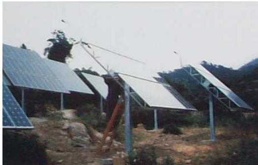
**Fig. 5.10. Conjunto de estructuras de apoyo único.**
