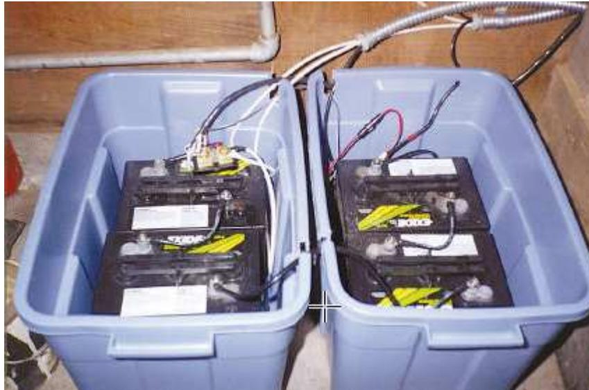
**Fig. 5.67.** Una forma alternativa es utilizar contenedores plásticos para proteger las baterías. Se realizarán unas perforaciones para pasar los cables, finalmente se tapanán con los respectivas tapas de los contenedores.
