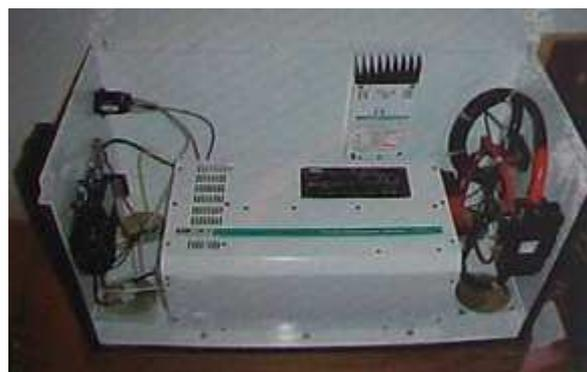
Fig. 5.77. Solución compacta y portátil que integra el regulador, el inversor, los interruptores automáticos y la monitorización en un mismo contenedor, diseñado específicamente por el fabricante
