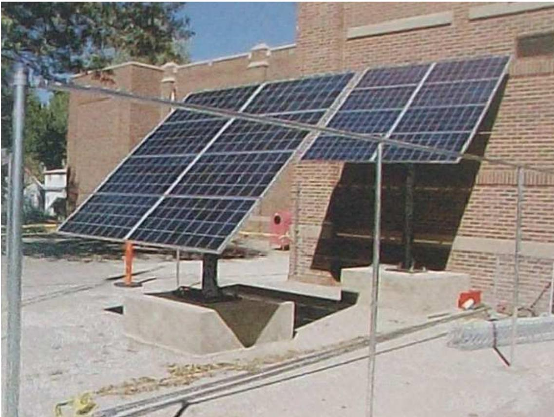
**Fig. 5.2. Colocación de una verja metálica que rodeará a los paneles y los aislará de la vía pública.**
