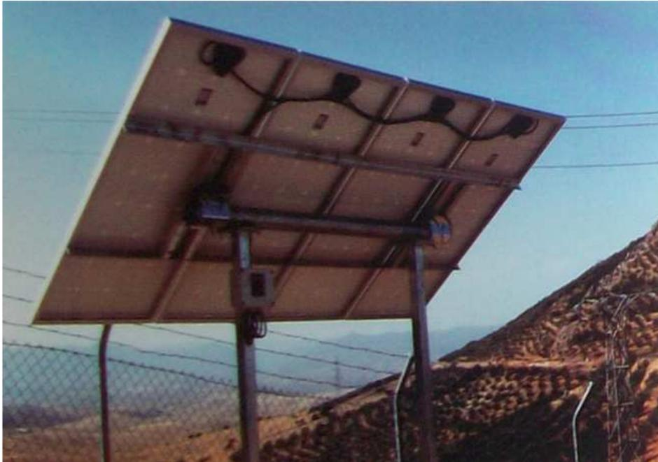
Fig. 5.90. La siguiente operación es efectuar la interconexión de los módulos, a través de sus correspondientes cajas de terminales, y agrupar los conductores en una única caja de conexión para todo el panel (situada en el apoyo izquierdo de la estructura).
