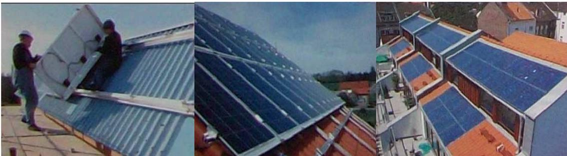
**Fig.5.30. Ejemplos de montaje de paneles fotovoltaicos en una cubierta inclinada.**
