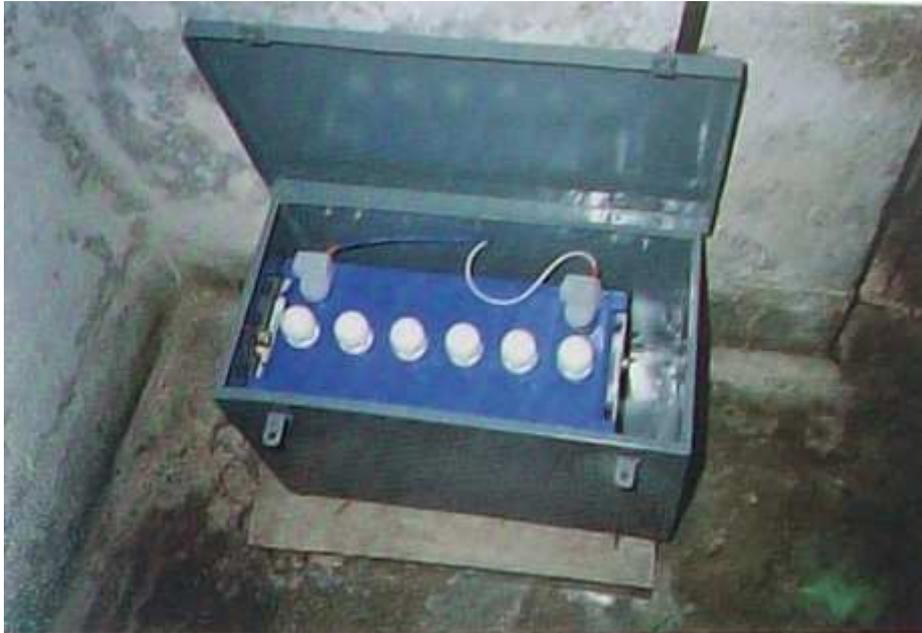
**Fig. 5.65** Obsérvense los protectores de los bornes y la falta de ventilación en la caja, que debería permanecer abierta durante la carga de la batería.
