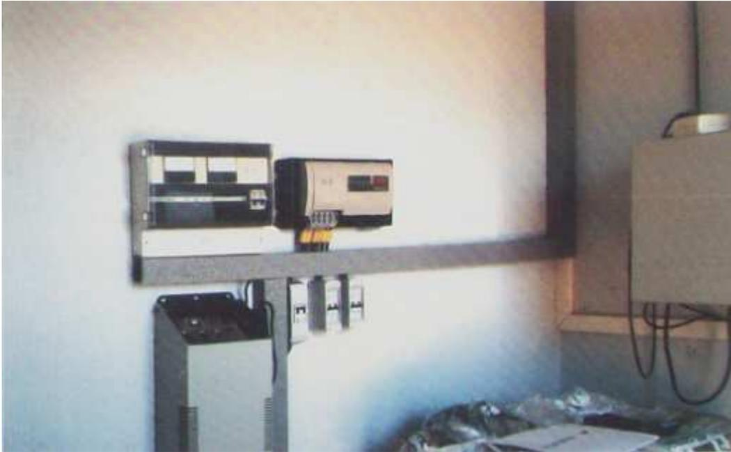
**Fig. 5.95.** Los elementos de regulación y control pueden montarse directamente sobre la pared. Todos los cables se agrupan y recogen en canaletas de material plástico, lo que mejora el aspecto estético, y disminuye el riesgo de accidentes.
