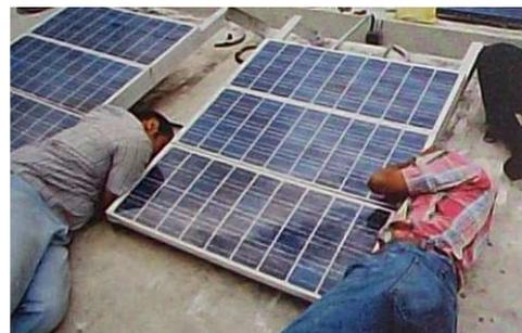
**Fig. 5.46.** Acceder a las conexiones de los módulos sin retirarlos de la estructura puede resultar, en ocasiones, una tarea difícil y poco recomendada.
