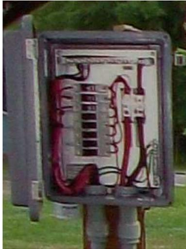
Fig. 5.41. Caja de conexiones principal de un sistema fotovoltaico con el negativo puesta a tierra. Obsérvense el descargador de sobretensiones.
