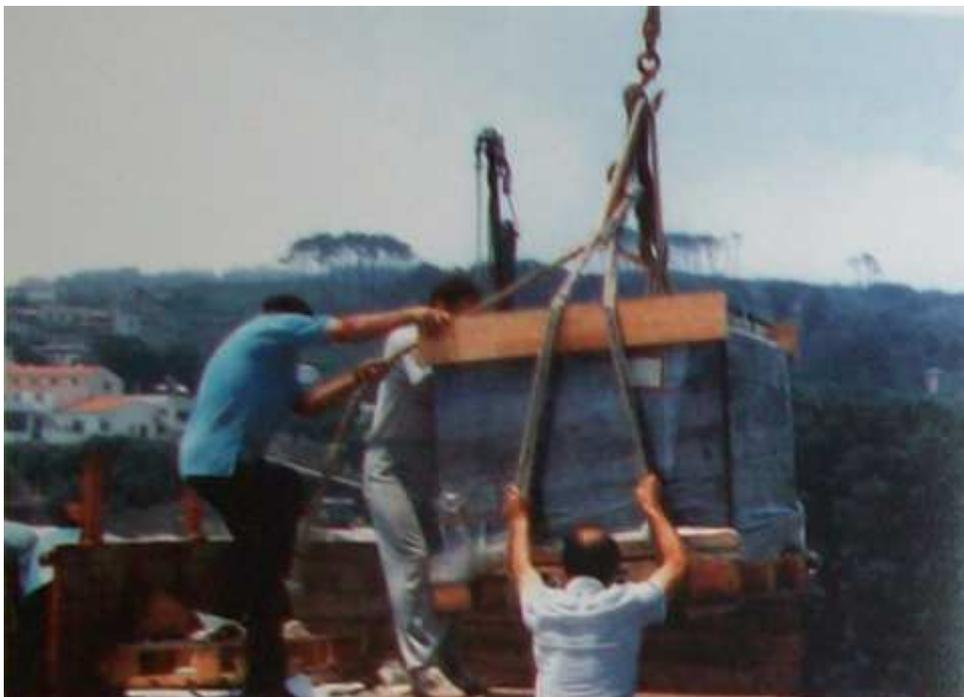
**Fig. 5.93.** Operación de descarga de los acumuladores, para la cual resulta imprescindible la utilización de los medios mecánicos.
