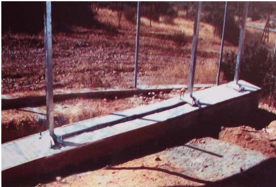
Fig. 5.91. El conductor general, convenientemente protegido, se lleva desde la base de la estructura a una canalización subterránea.
