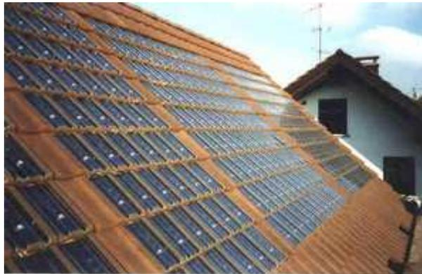
**Fig. 5.5.** Módulos fotovoltaicos especiales, contruidos en forma de tejas, que pueden sustituir a éstas en un tejado convencional e integrarse perfectamente en el mismo.
